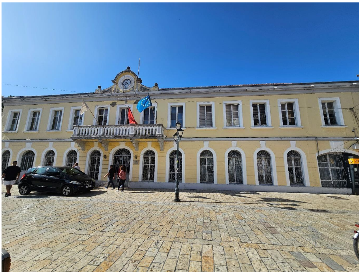
Foto 4. Foto e fasadës kryesore
